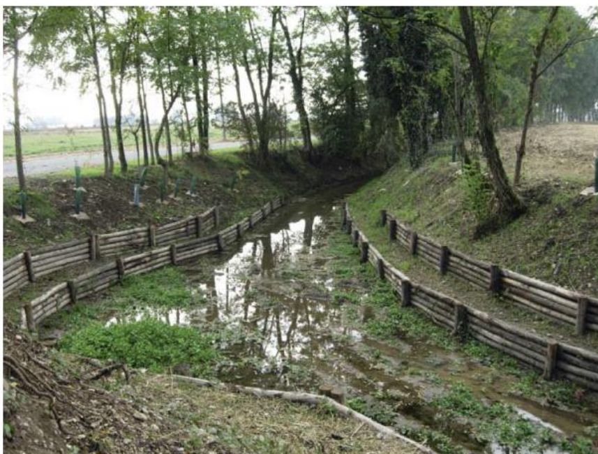
Figura 4. Strutture in legno per il contenimento delle sponde
